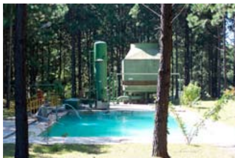
Estação de Tratamento de água industrial
